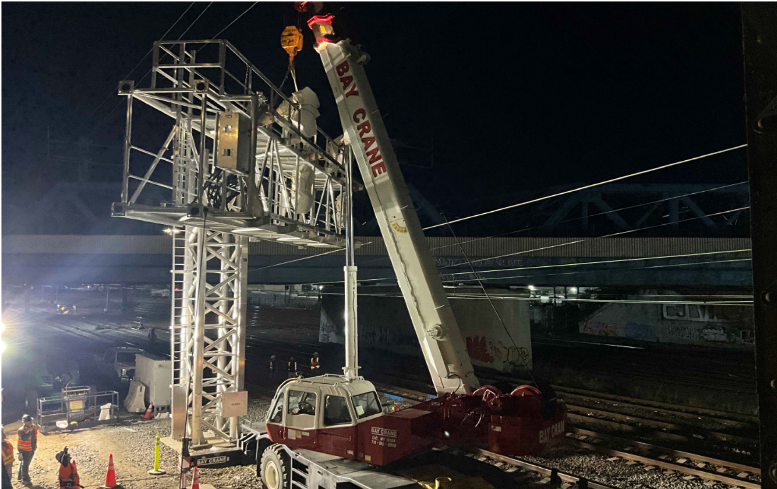
Nuevo puente de señales en Leggett Interlocking - diciembre de 2024
